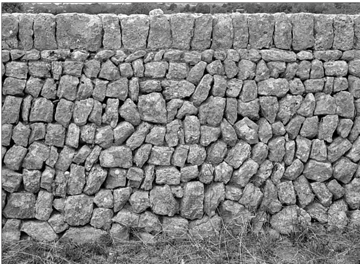
Fotografia 5: Vista lateral d'una paret de doble encadenat.
