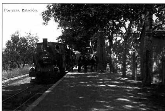
Locomotora Nasmyth Wilson a l'estació de Porreres. Arxiu Andreu Muntaner.
