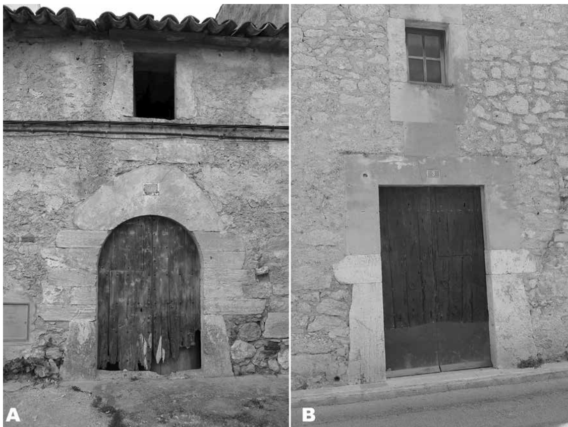
Figura 6 – Exemples d'utilització de pedra de Son Vadó en la construcció: A. Casa del carrer del Pou Florit núm. 77, B. Brancals del portal del molí de n'Amengual, al carrer d'en Dusai, núm. 3.
