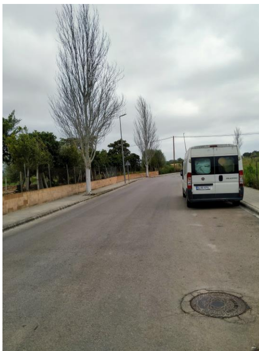
Fotografia 3. El carrer Illes Balears ja es troba executat.
