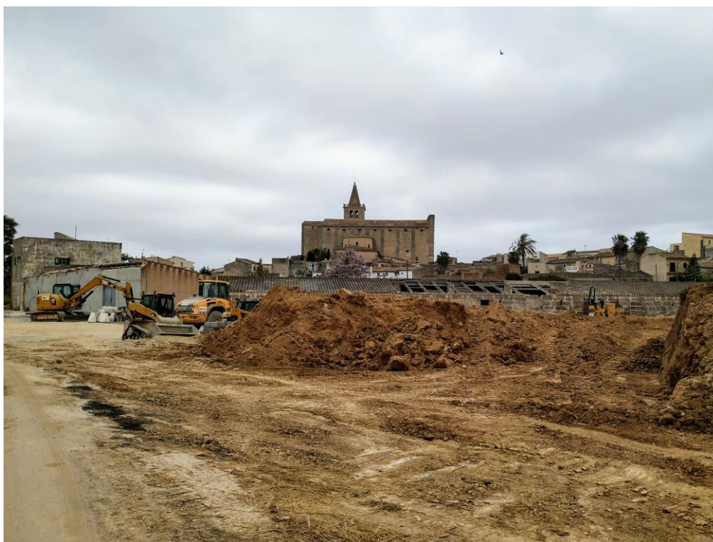
Fotografia 1. S'observa com ja s'han iniciat les obres de la Ronda.
