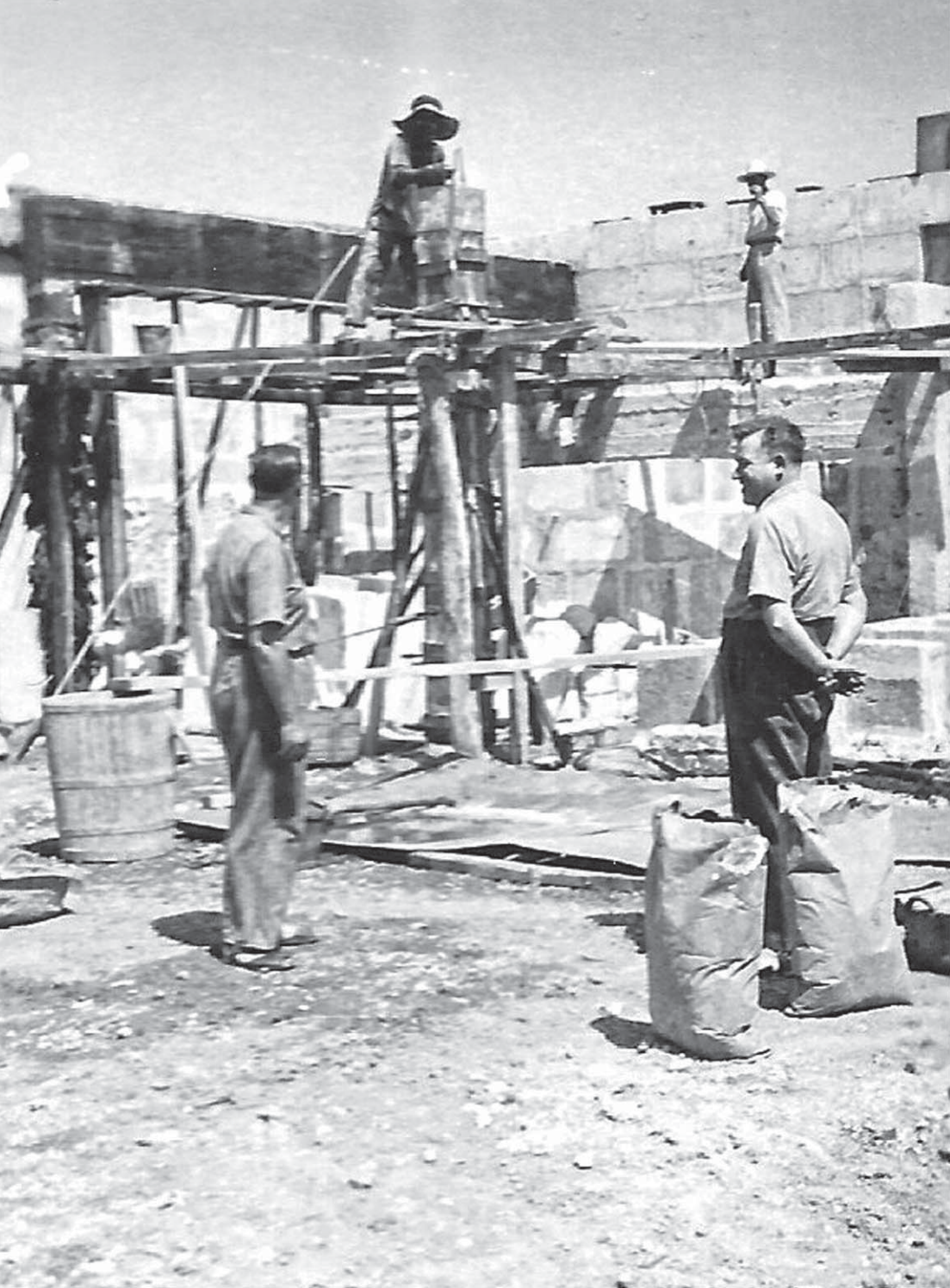
Construcció del magatzem de Can Boterí, juliol 1952.
