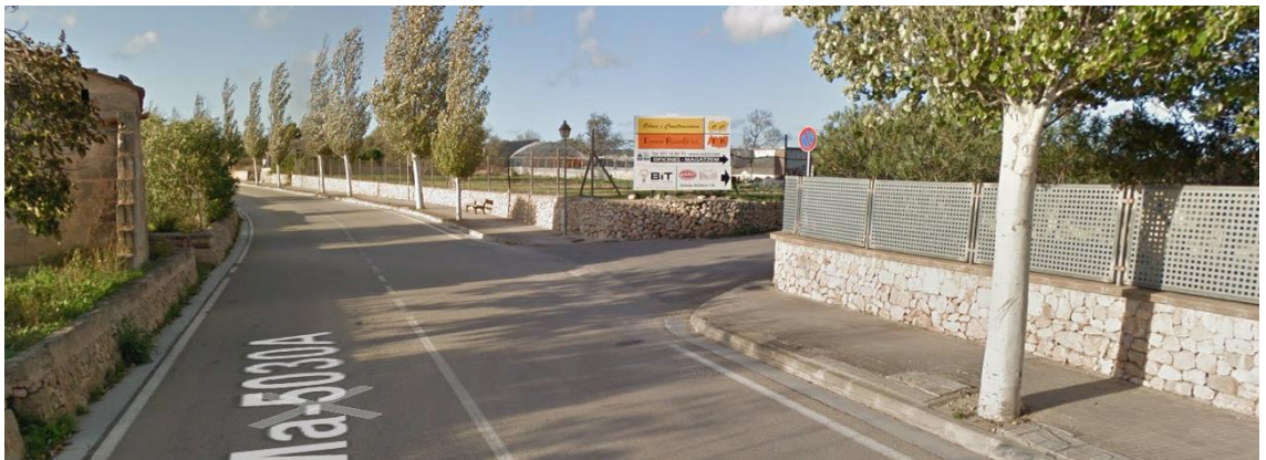
Vista de l'actual vial d'accés a la nau industrial situada a l'est de l'institut (a dalt) i del seu encontre amb la Ma-5030A (a baix). Google Street View (Captura de novembre de 2019)
